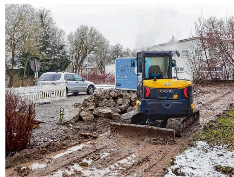
Die Arbeiten laufen. Im Hintergrund ist der Kindergarten zu sehen, davor die provisorische Heizzentrale. Foto: Wolfgang Pfister
