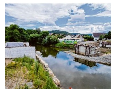
An der Brücke bei Münster ruhen die Bauarbeiten. Foto: Archiv
