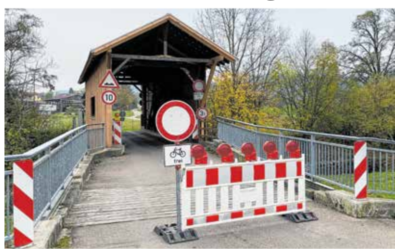
Die Holzbrücke in Kleinaltdorf ist für Pkw gesperrt. Foto: Axel Theurer
