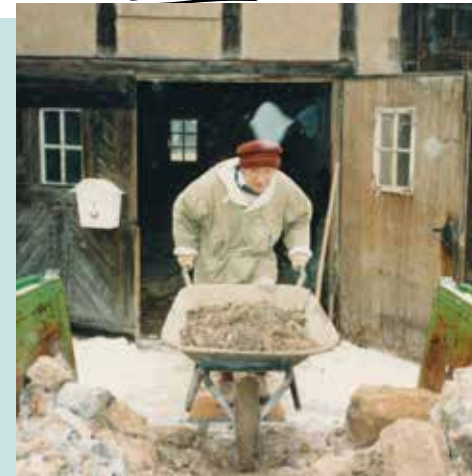
Michael Turzer bei den Umbauarbeiten
